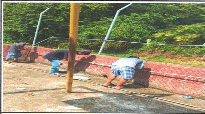
Sustitución de malla, pintura de muro interior y exterior
