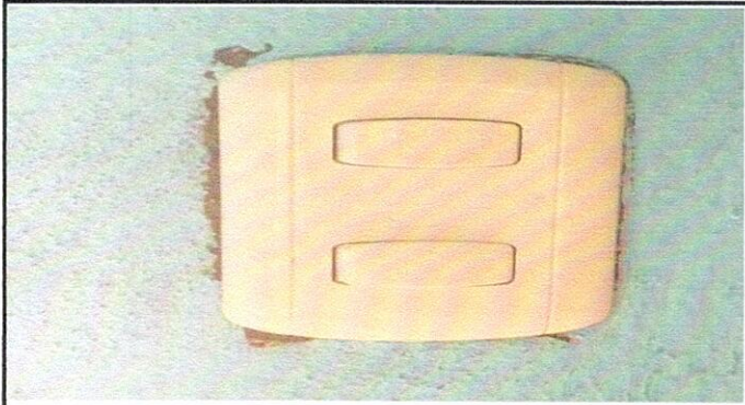
Sustitución de tomacorriente
