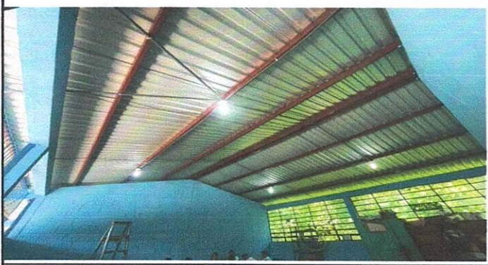
Reparación de sistema eléctrico
