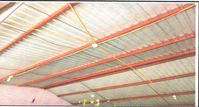
Reparación de Sistema Eléctrico
