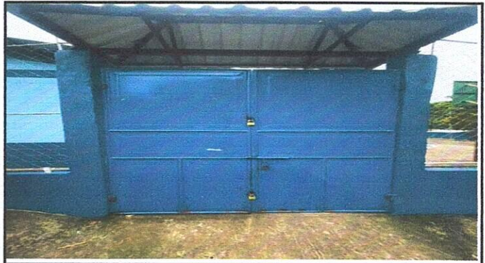
Sustitución de Portón
