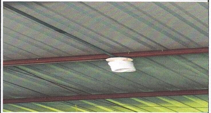
Reparación de Sistema Eléctrico
